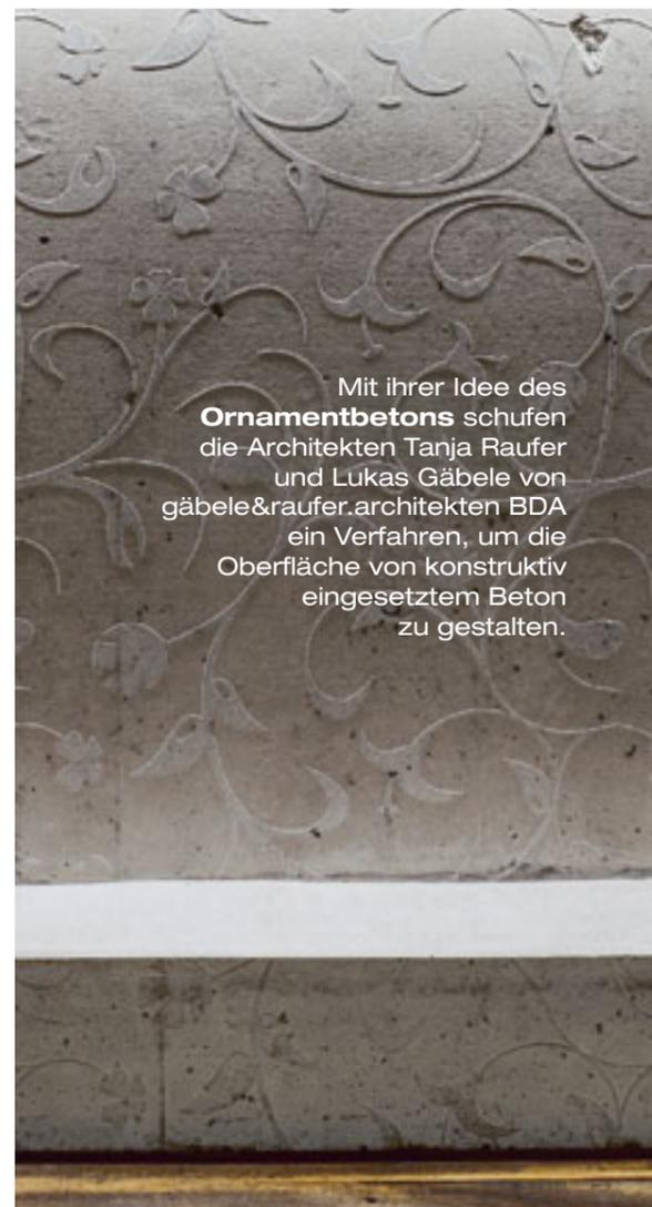
Mit ihrer Idee des **Ornamentbetons** schufen die Architekten Tanja Raufer und Lukas Gäbele von gäbele&raufer.architekten BDA ein Verfahren, um die Oberfläche von konstruktiv eingesetztem Beton zu gestalten.
